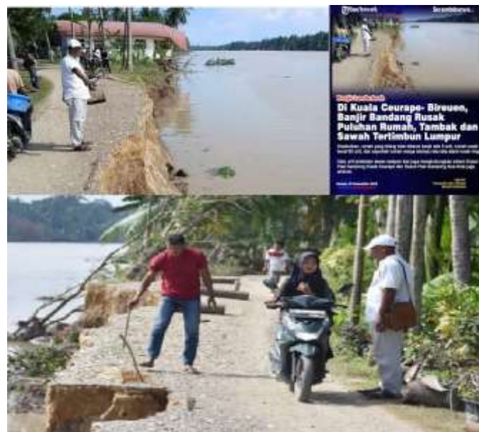
Gambar 1. Kondisi Desa Kula Ceurape Jangka Kabupaten Bireuen, Berdampak Bencana
