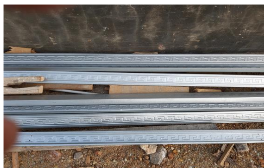
Gambar 5. Profil Baja Ringan yang digunakan sebagai Kuda-kuda
