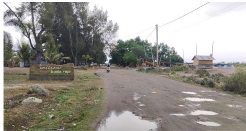
Gambar 6. Kondisi Jalan Menuju Kawasan Babah Kuala
