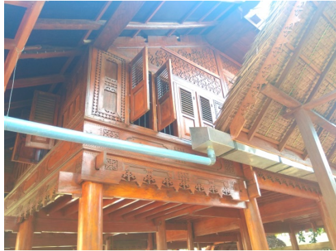
Gambar 4. Papan dinding yang dipasang secara horizontal
