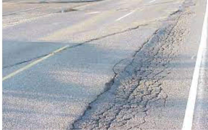
Alur adalah deformasi permukaan perkerasan aspal dalam bentuk turunnya perkerasan ke arah memanjang pada lintasan roda kendaraan.
