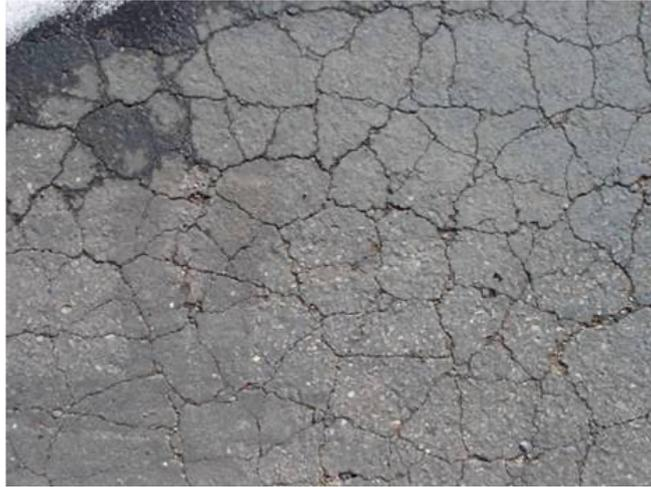
Retak blok ini berbentuk blok-blok besar yang saling bersambungan, dengan ukuran sisi blok 0,3 sampai 3 m dan dapat membentuk sudut atau pojok yang tajam.
