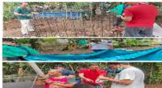
Gambar 3. Perakitan Kawat Besi Kolam Bioflok
