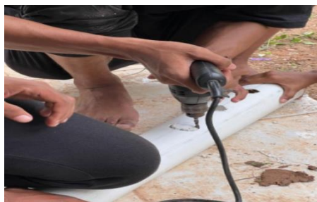
Gambar 2. Pembuatan Biopori sebagai Pengolah Sampah Organik Rumah Tangga
