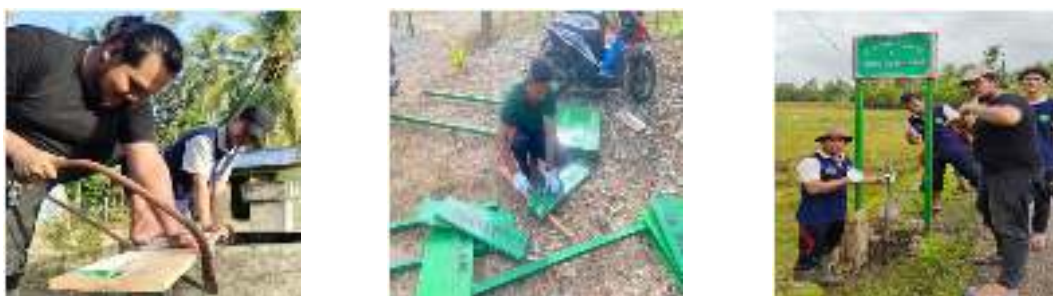
Gambar 13. Proses Pembuatan dan Pemasangan Penanda Lorong
